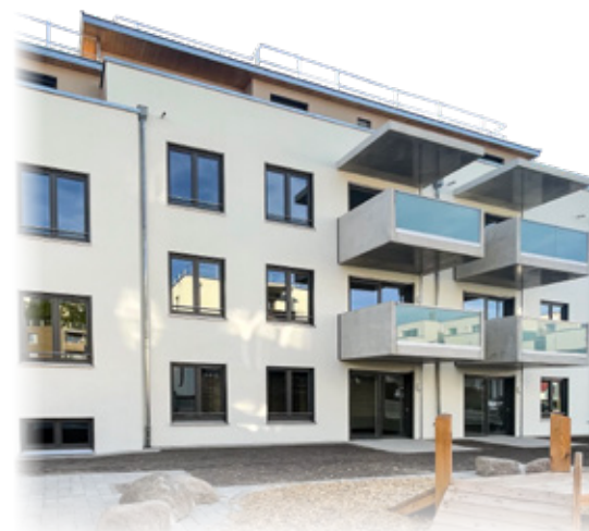
Attraktives Wohnen in Neckarweiningen: 53 Wohnungen für alle Generationen.
