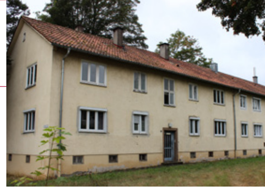
Zwischen Oder- und Elbestraße werden in diesem Winter weitere Gebäude abgerissen.
